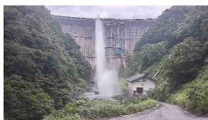
写真1 ダム堤体正面
