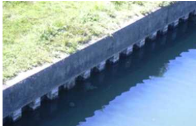
図-4 野洲川河口部の矢板護岸構造
