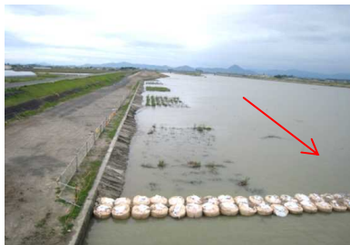
図-5 野洲川右岸ヨシ帯再生工事施工後(2010年4月)
