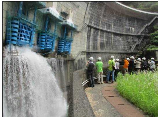
写真-2 コンジットゲート点検放流
