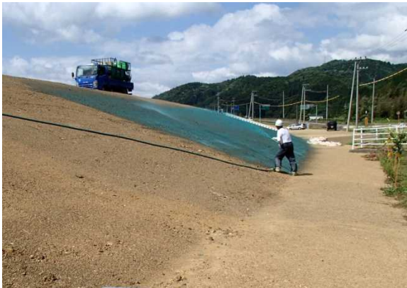
図-9 改良ムカデシバの種子吹付状況
