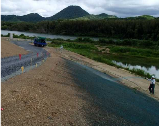
図-5 ノシバ種子吹付の施工状況
