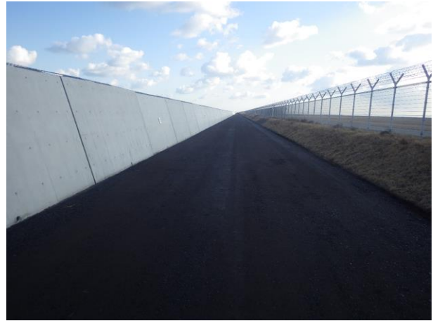
写真-7 嵩上げ後の2期島護岸（制限フェンス移設前）
