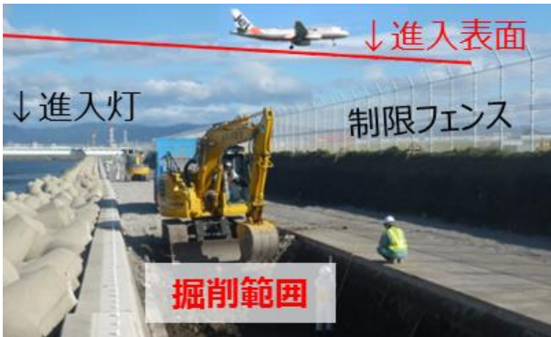
写真-3 A1護岸施工風景
