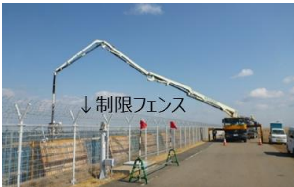
写真-4 A2護岸施工風景
