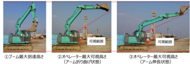
図-6 バックホウの作業高さ管理
