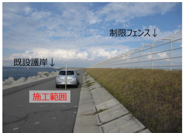
写真-1 2期島A3護岸施工前風景
