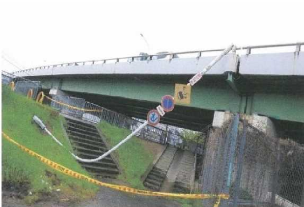
写真-1 石切跨道橋
