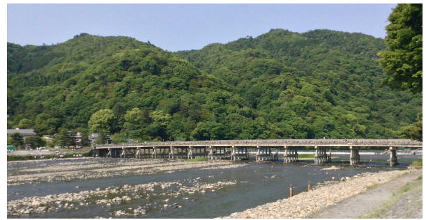
写真-2 桂川・天竜寺観測所付近
