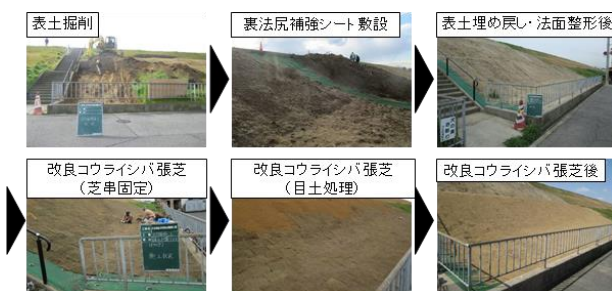
図-6 植生転換の施工状況
