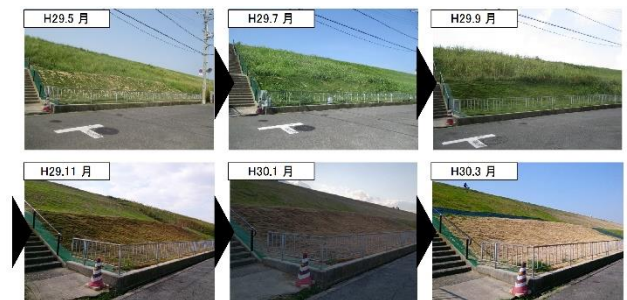
図-6 植生転換箇所の経過状況（全景）
