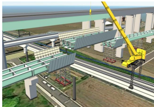
(b) トラッククレーン架設
