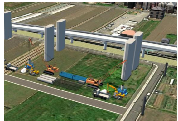
(a) 杭施工時
