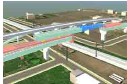
(a) 送り出し架設
