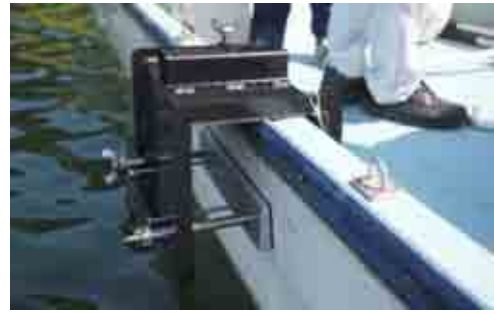
写真-12 作業船両縁に取付け金具を装着
