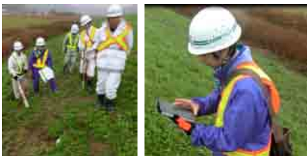
図12. CalSok計測データを用いた目視点検の様子
