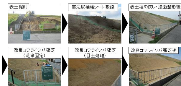
図-6 植生転換の施工状況
