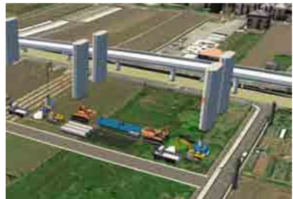
(a) 杭施工時
