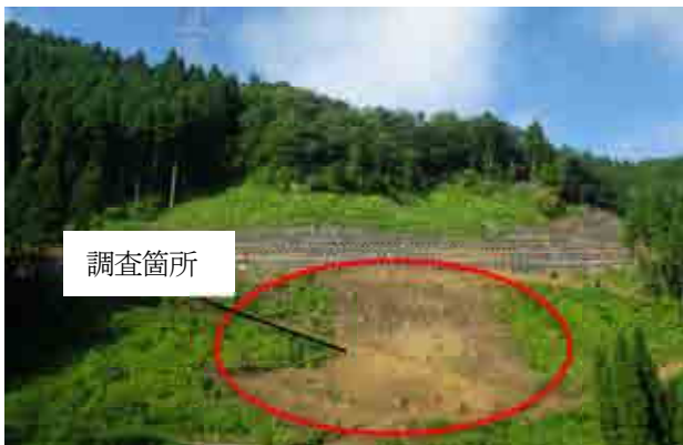
図-9-1 調査箇所の状況 (2015年8月)
