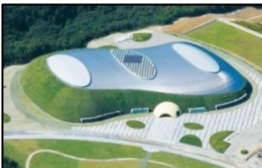
図-1 ビーンズドーム外観
