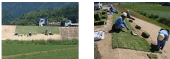
図16. 各低草丈草種の張り芝施工状況（施工中）
