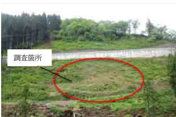
図-9-2 調査箇所の状況 (2018年5月)
