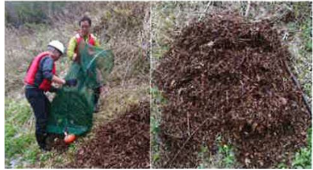
写真-20 回収ネット底を緩め斜面にマルチング材利用
