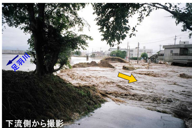
写真-1 足羽川破堤地点
