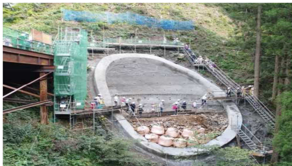
写真-3 付替県道橋梁下部工見学
