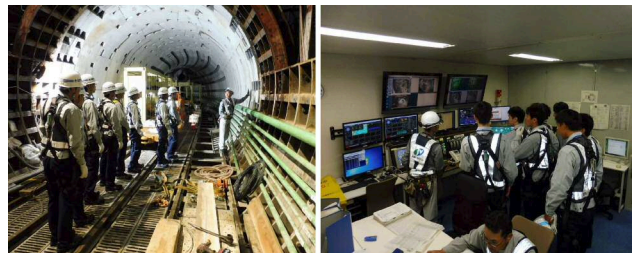
写真-6.2 (左) シールド工事 (右) 同左 集中管理室
