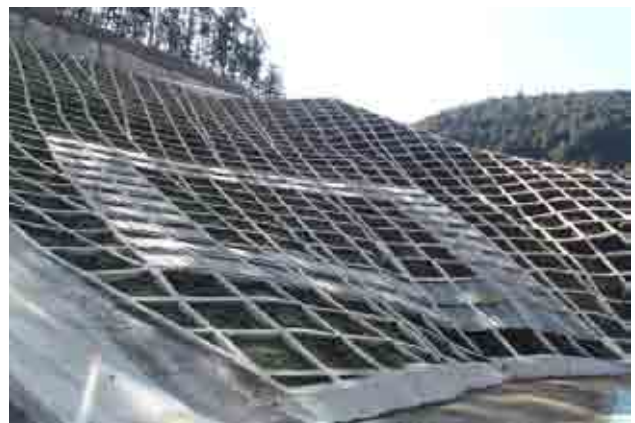
図-12 施工直後の様子(2017年2月)
