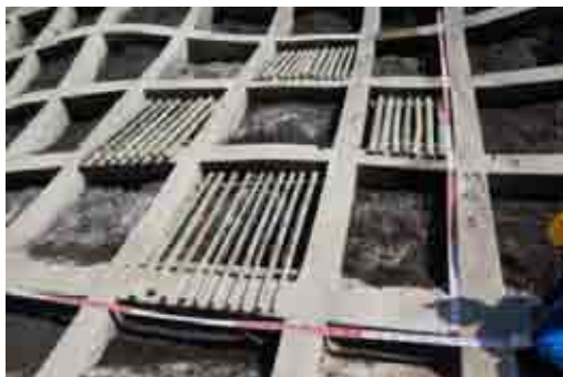
図-3 法枠工内の設置状況
