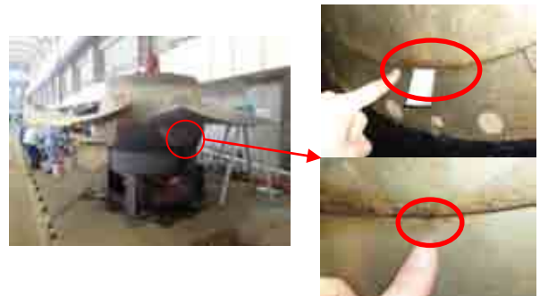
写真-1 ポンプインペラハブ漏油状況 2)
