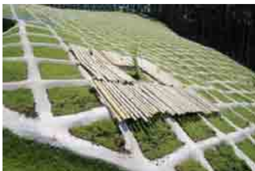
図-4 簡易法枠工内の設置状況
