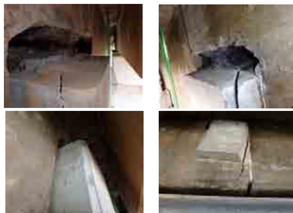
【第4径間起点側】
