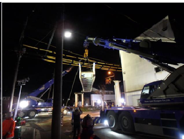
図-5 通路部撤去状況写真(左：建部歩道橋 右：東中野歩道橋)
