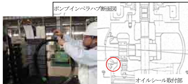
写真-5 オイルシール硬度測定状況
