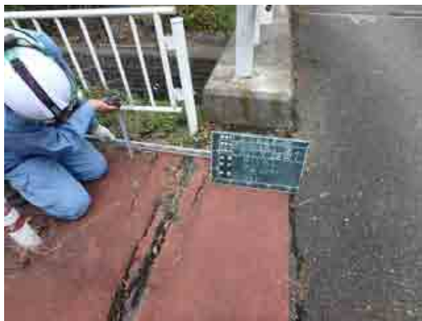
写真-05 橋面 遊歩道との段差 95mm
