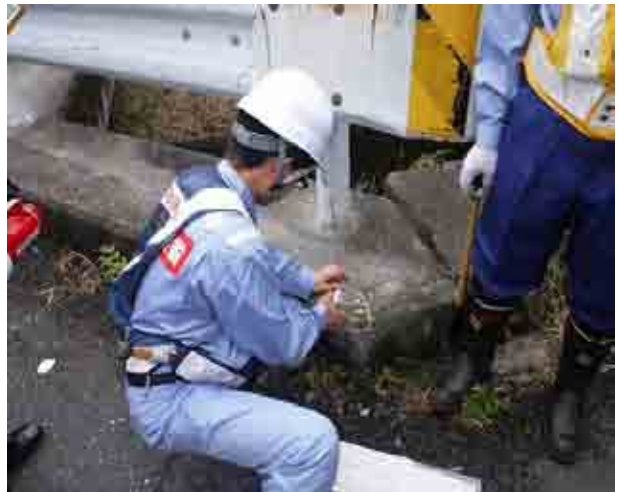
写真-01 点検状況
