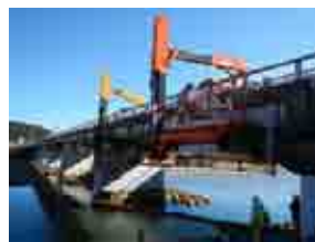
【点検車による近接調査】
