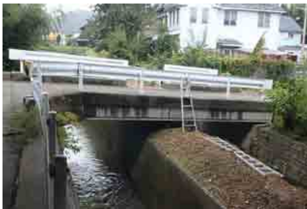
写真-03 今津川副道橋上り
