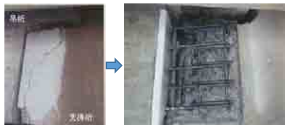
【ポリマー系断面修復後のひびわれ】
