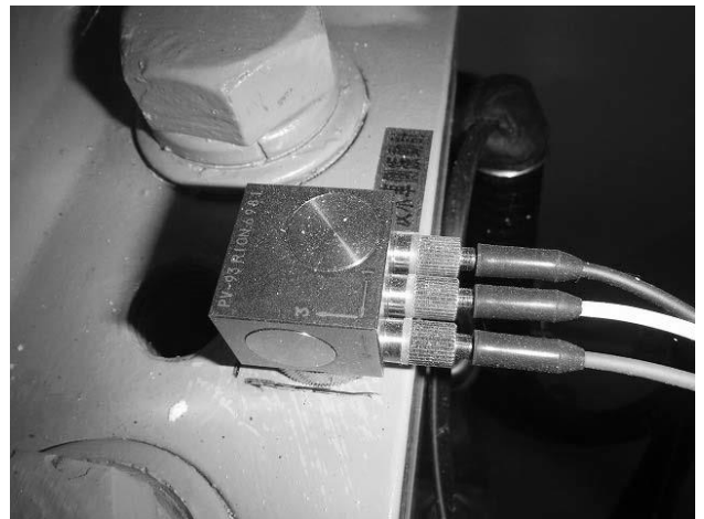
写真-2 振動センサー（取付状況）
