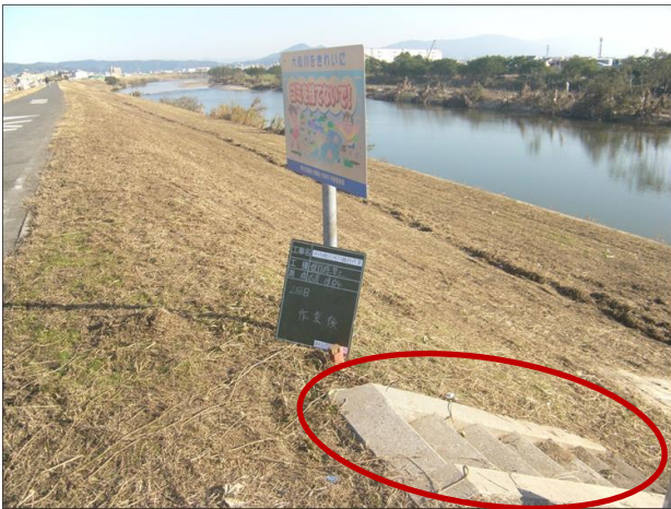
図-3 除草後の状況
