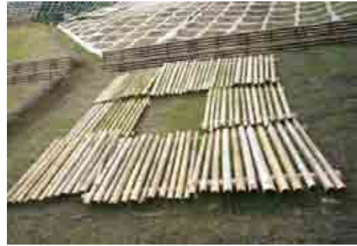
図-5 伏工内の設置状況
