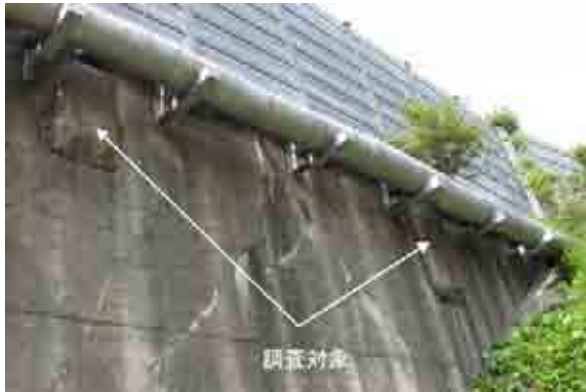
写真-3 既存定着部の調査対象
