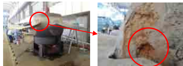
写真-6 ポンプインペラハブ腐食状況
