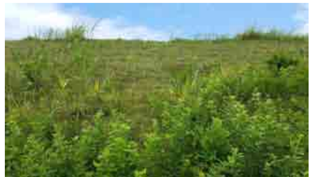
図-16 平成29年7月の淀川左岸6.6k付近の状況
