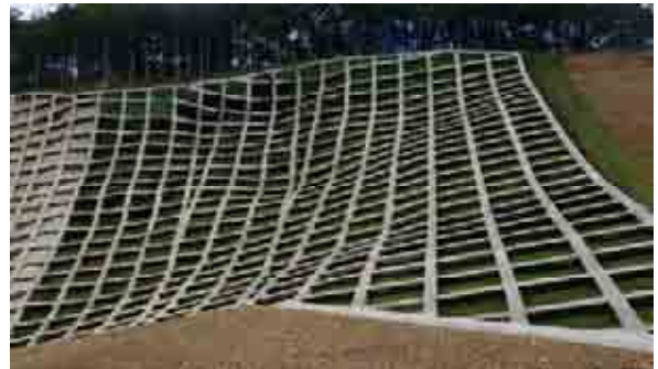
図-1 2014年度施工の法枠工
