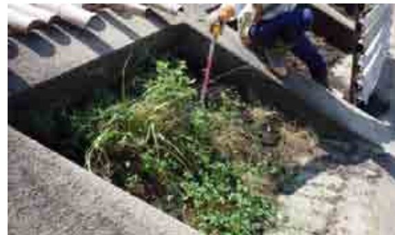
図-6 法枠工内の生育状況
