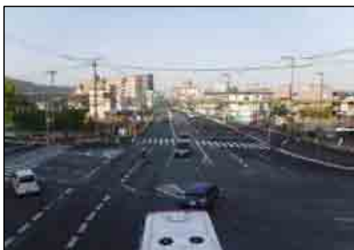
写真4 国道171号神戸向きの状況(整備後)
