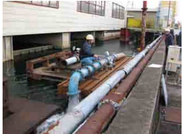
図-4 工場試験設備による測定状況
