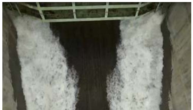
写真2 開度92cm時の放流状況
