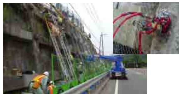
写真-4 リフトオフ試験実施状況
