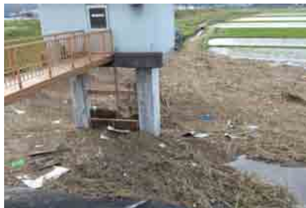
写真-1 遊水地内ゴミ堆積状況(小田)
