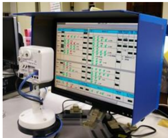
図-3 カメラ設置状況
