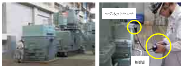
写真-2 振動測定実施状況
