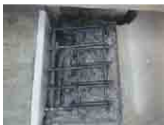
写真-11 過年度配筋状況
