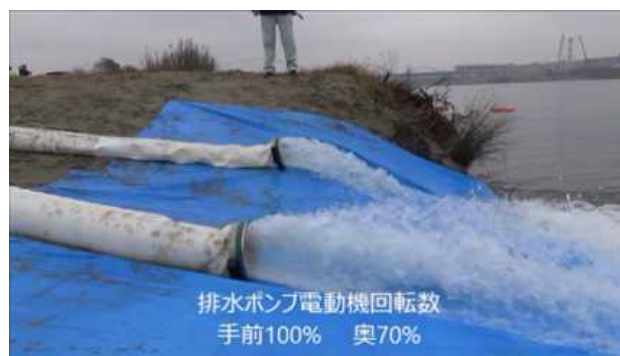
図-7 排水量低下確認の試験状況
