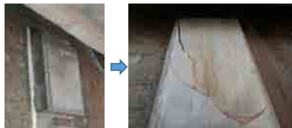
【補強鉄筋による断面修復】
