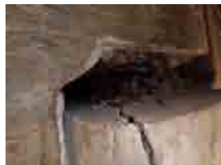
【再劣化したひびわれ】
