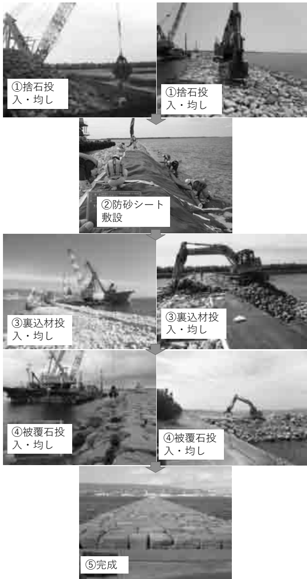
写真-5 東側護岸 (3, 4工区) 施工状況
