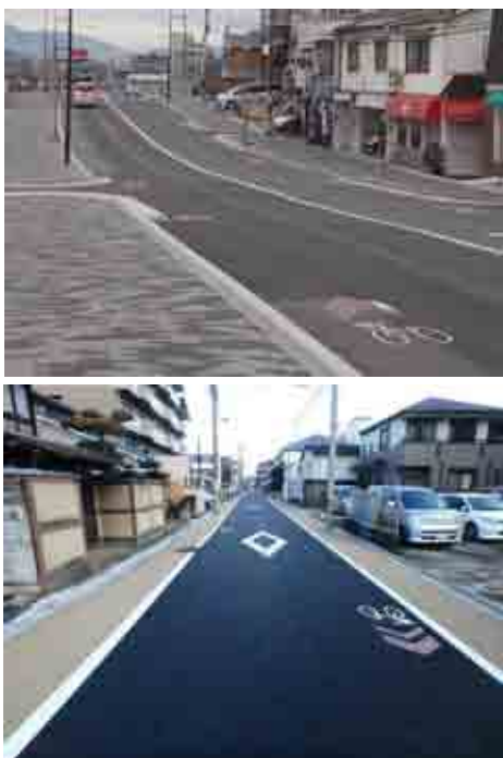
図-10 道路改良工事等に併せた整備
