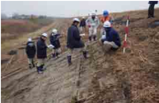
写真-2 合同点検状況
