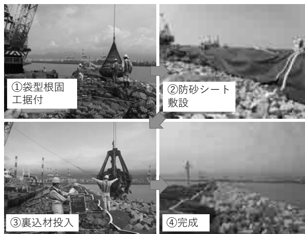
写真-4 西・南側護岸(1, 2, 5工区) 施工状況
