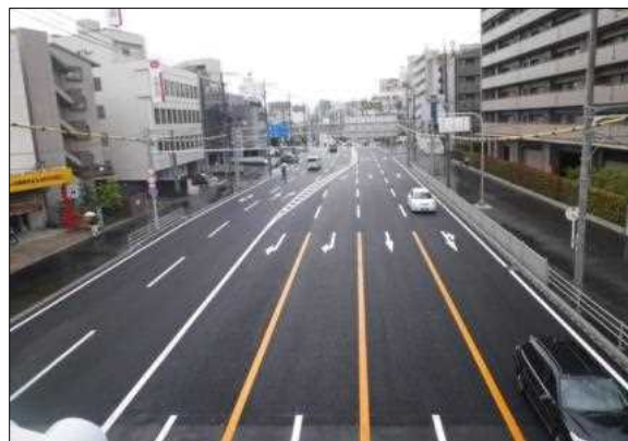
写真-3 国道171号京都向きの状況(整備後)
