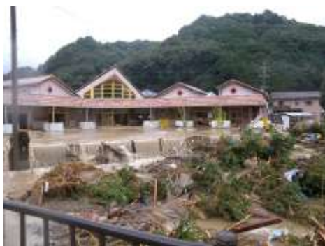
図-3 保育所（避難所）の被災状況
