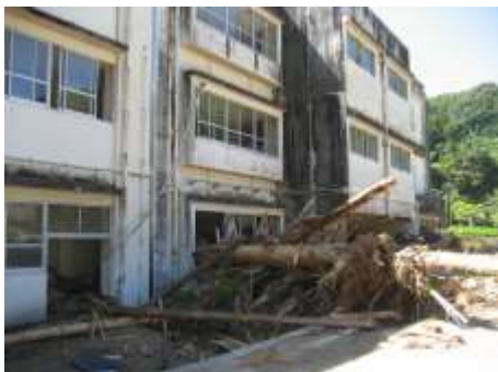
図-4 小学校（避難所）の被災状況
