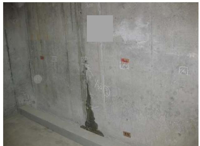
写真-13 漏水箇所の例
