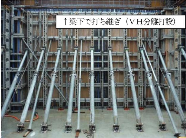
↑梁下で打ち継ぎ（VH分離打設）
