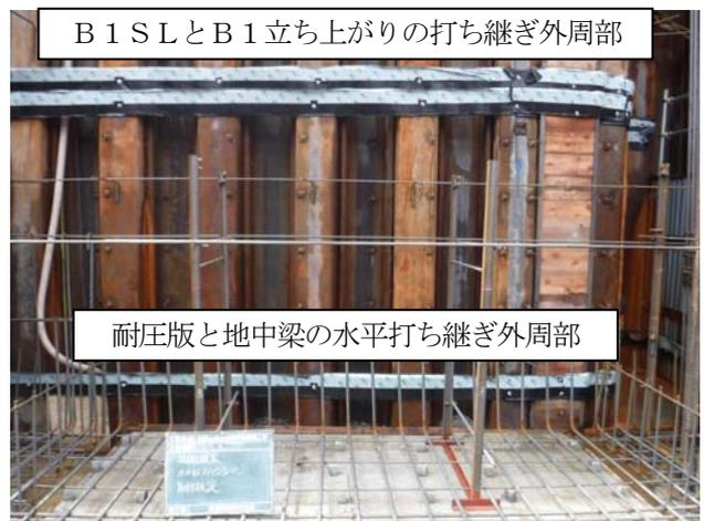
写真-2 水平打ち継ぎの止水対策
