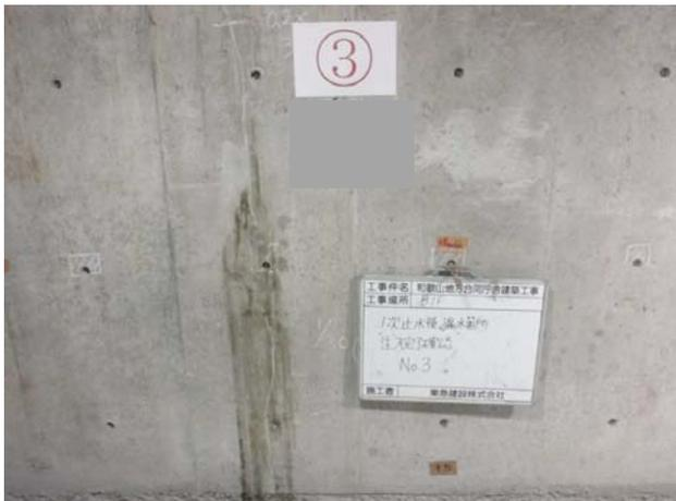
写真-14 止水処理後の状況
