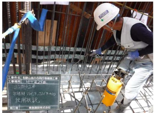
写真-3 水平打ち継ぎの止水対策
