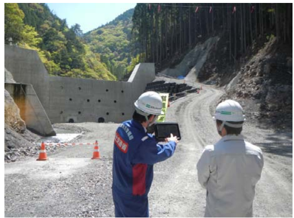
図-13 現地対応システムを活用しての住民説明（過去計測データと見比べ工事の進捗を説明することに活用）
