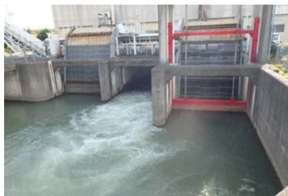
写真-8 ポンプによる浄化運転状況
