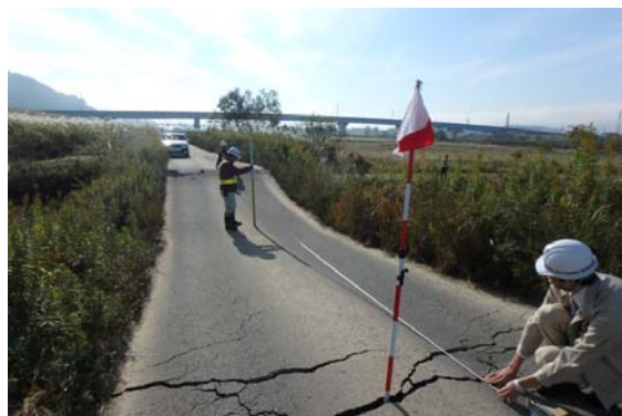
写真-7 工事用道路の陥没
