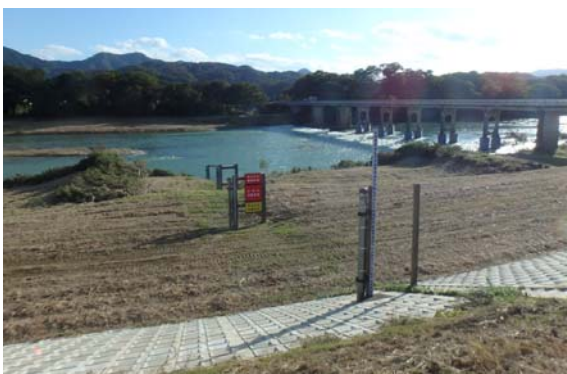
写真-6 水位観測所の状況
