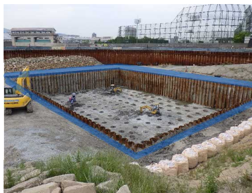
写真-3 遮水対策後の掘削状況
