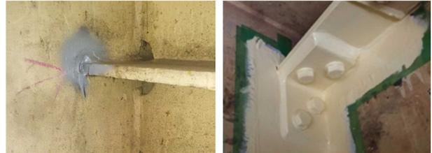
写真5 あて板補強工
