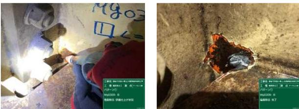
写真4 削り込み工
