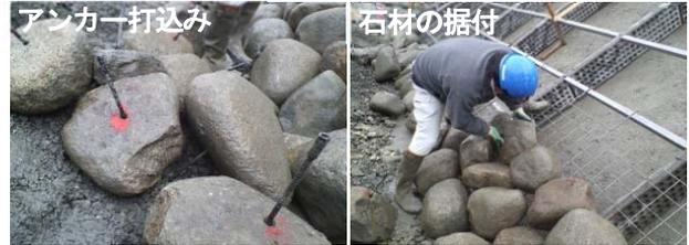
写真4 背面アンカー一体型護岸施工イメージ
