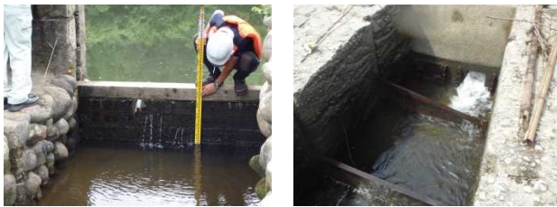
図-2 各魚道の課題箇所(左:相楽発電所取水堰魚道の落差 右:大河原発電所取水堰魚道の潜孔 ※いずれも魚道内の流量を下げ、水位を低下させた状態で撮影)
