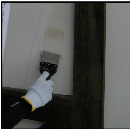
図4 外壁補修部分の下処理（パテ処理）
