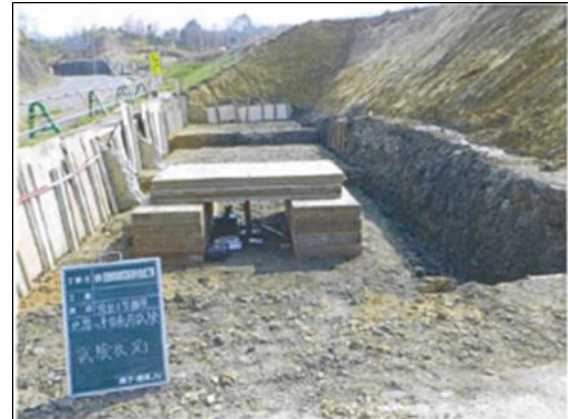
写真-1 地耐力の確認状況
