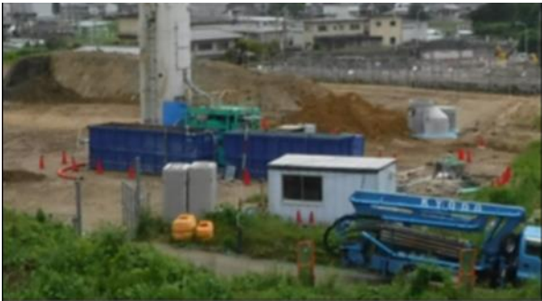
写真-4 プラント設置状況
