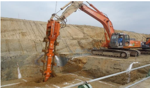
写真-3 トレンチャ式攪拌混合機
