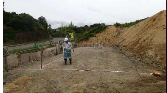
写真-5 地盤改良工の完了状況
