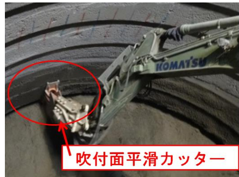
図-10. 吹付面平滑カッターと吹付面
