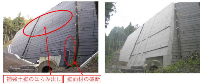
写真-4 追加補強工事前後
