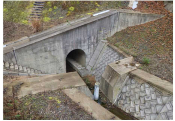
写真-3 アーチカルバート上流側状況
