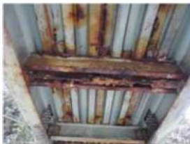
橋梁定期点検時の写真
