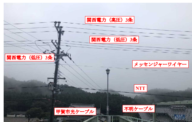
写真-2 架空線の配置図
