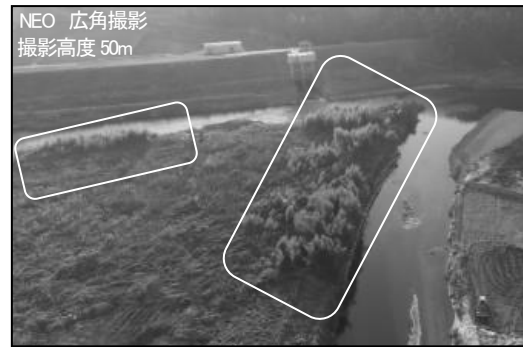
写真-5 樹木繁茂の状況確認
