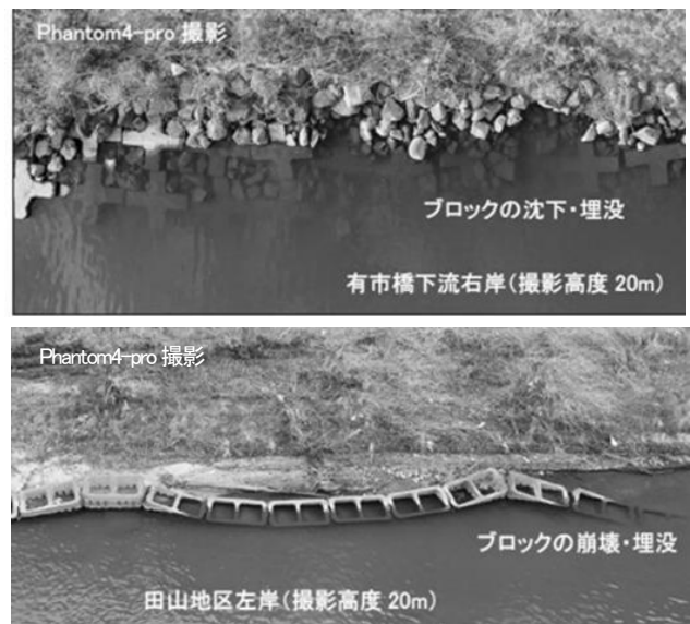
写真-9 根固めブロックの状況確認
