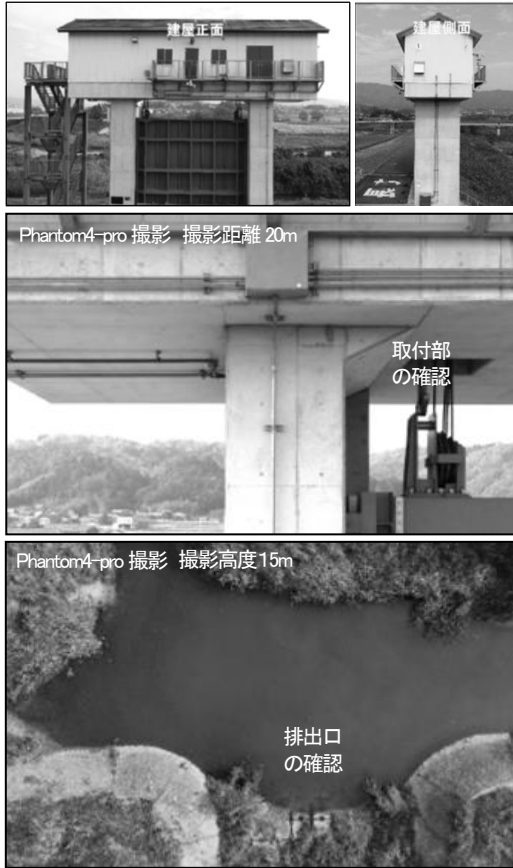
写真-7 水門の状況確認
