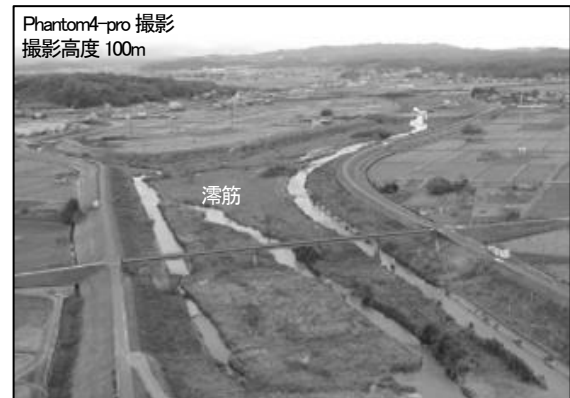
写真-1 河道状況の確認
