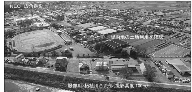
写真-11 堤内地の確認
