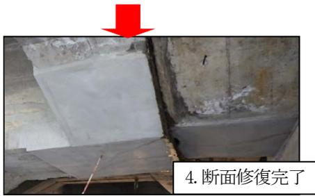
写真-8 上部工(下面部)の断面修復施工状況
