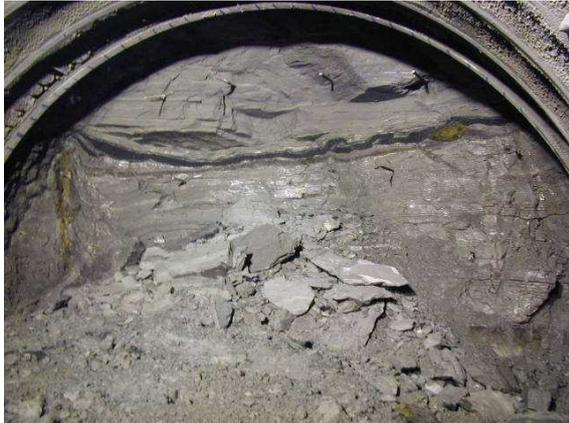
写真-1 切羽崩壊の例（天端崩落）
