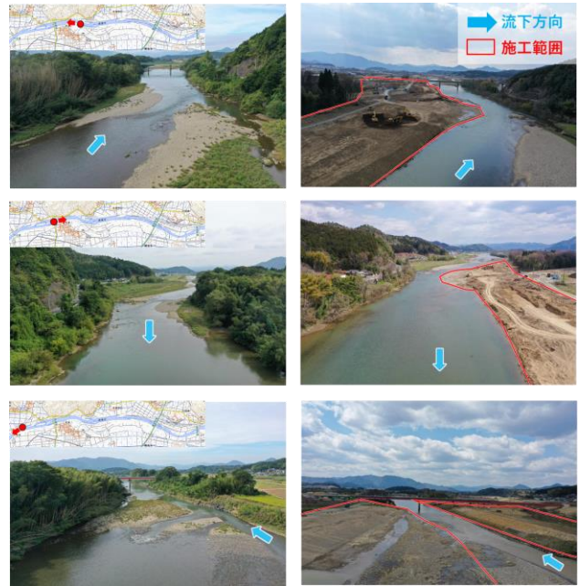
図-11 河道掘削工事施工前後でのドローン空撮。左が施工前（2019年10月）、右が施工中（2020年3月）撮影。撮影位置については、各々42k付近（上）、41.8k付近（中）、41k付近である。なお本工事では河道掘削に加え樹木伐採も実施している。
