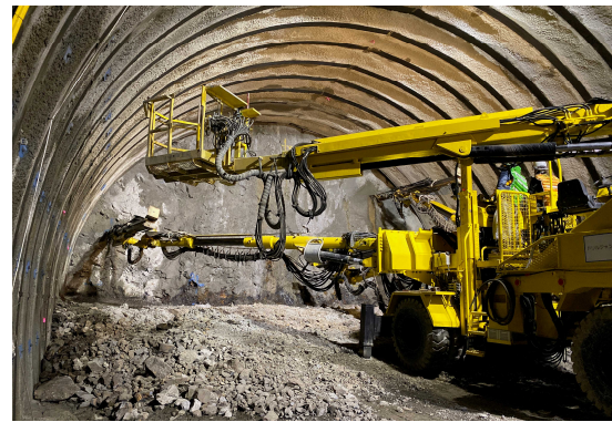
図4-4 ドリルジャンボの穿孔作業状況
