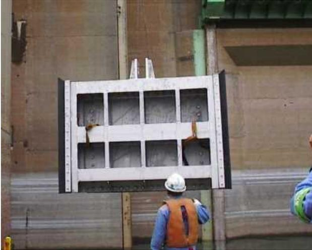
写真-1 補助取水ゲート更新状況
