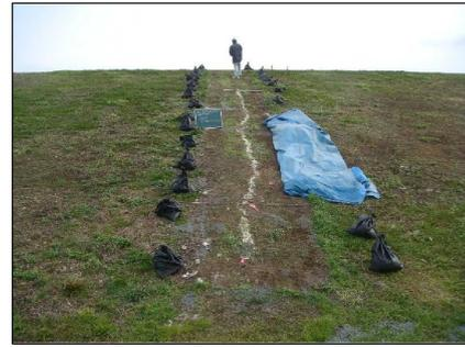
写真-1 地盤改良の境界に発生したクラック（隣接工区）
