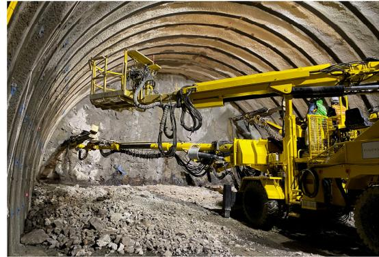
図4-4 ドリルジャンボの穿孔作業状況
