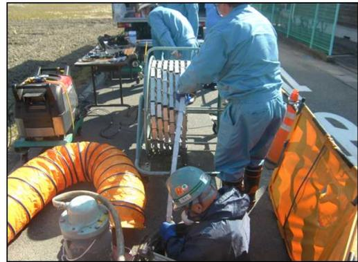
写真-3 ガイド挿入式カメラ調査状況
