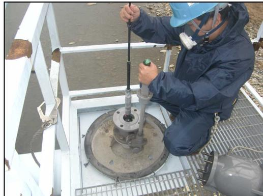
写真-4 挿入式カメラ調査状況
