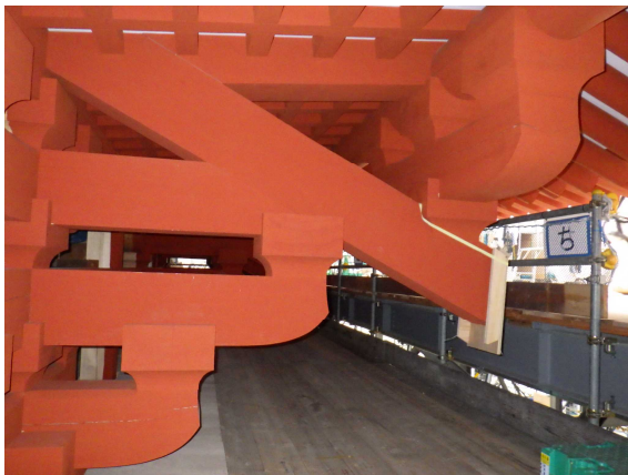
図-10 二重の屋根を支える組物 (2020年(令和2年)5月撮影)
