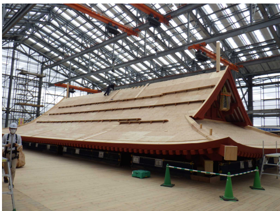
図-11 二重屋根 (2020年(令和2年)5月撮影)
