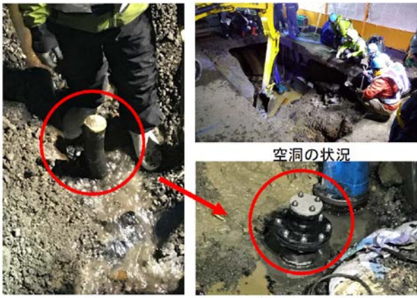
漏水箇所の発見 (木栓打ち込み後) 補修完了の状況 (鉄管溶接接合及び鉄蓋ボルト接合)
