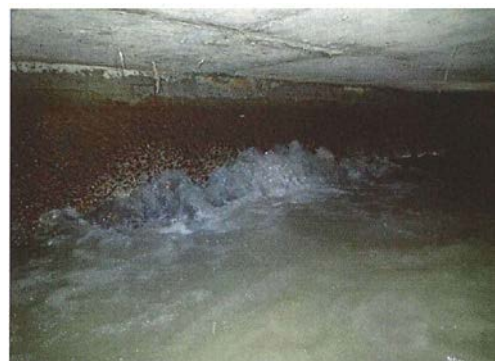
写真-1 1月8日 国道下暗渠水路内の状況 （水路底面部（側壁部分）から水の噴き出しを確認）
