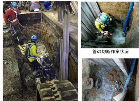
道路の開削状況
