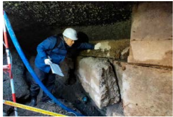
写真-6 修繕工事中の副所長級による路面空洞確認状況
