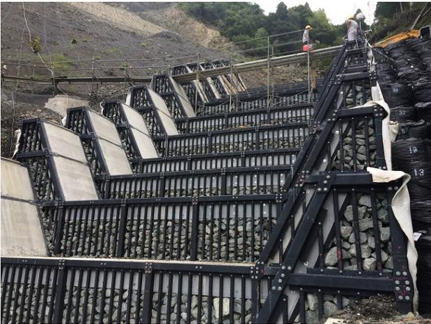
図-6 鋼製続枠設置状況
