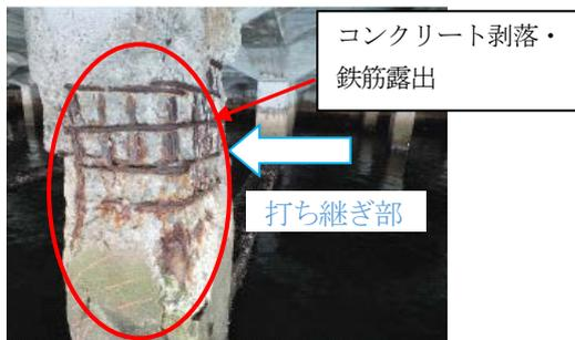
写真-4 脚柱部の老朽化状況
