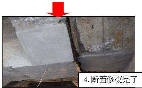
写真-8 上部工(下面部)の断面修復施工状況
