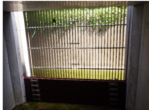
写真-4 取水口堰板
