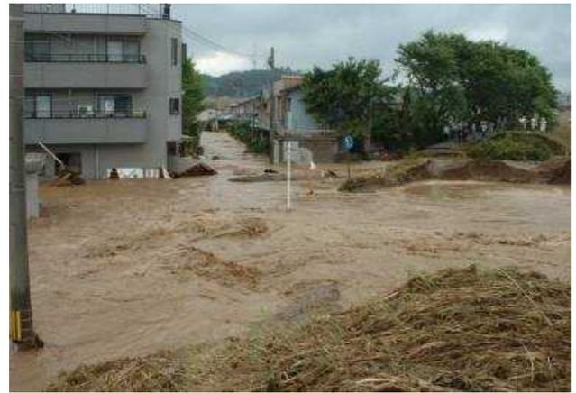
図4 2004年7月福井豪雨時の足羽川の破堤の様子
