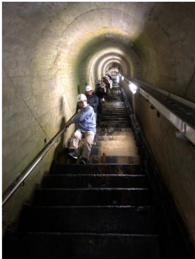
写真-6 監査廊階段(約 60 段,18m)
