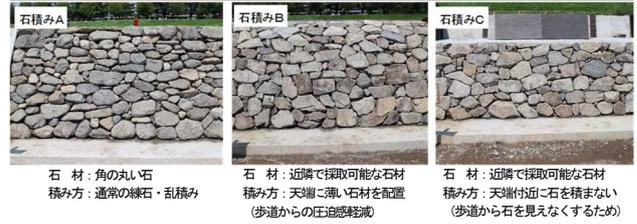
図7-7 試験施工結果(川側石積み)
