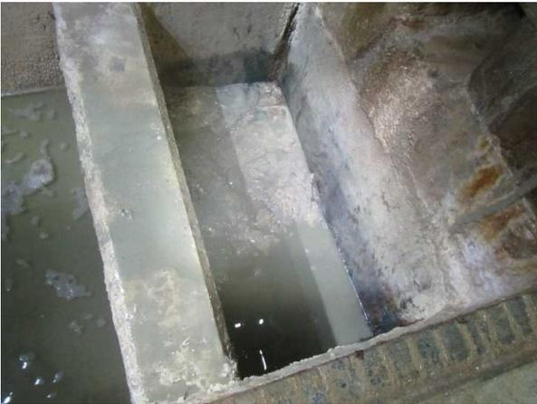
写真4 堆積したエフロへの試験施工状況
