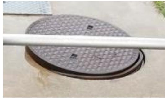
図-3 マンホールの脱落
