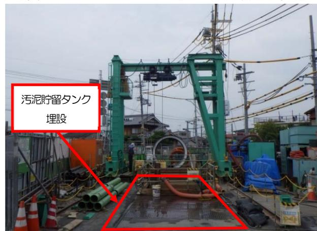
写真-5 機器（汚泥貯留タンク）埋設状況
