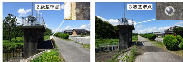
写真-5 2級・3級基準点(水門等に設置)
