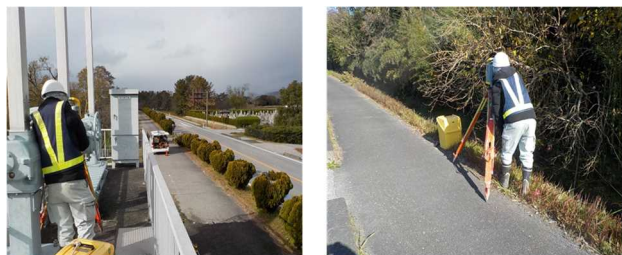
写真-6 トータルステーションによる復元作業
