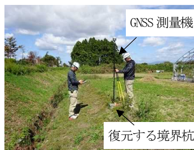
写真-9 GNSS測量機による復元作業
