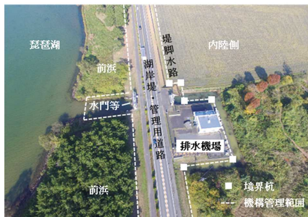
写真-1 境界杭の設置状況
