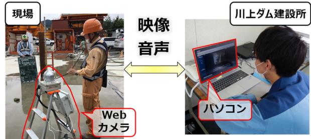
図-7 遠隔臨場の実施状況
