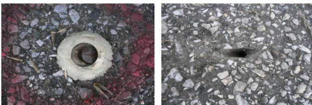
写真-7 損傷・亡失した4級基準点
