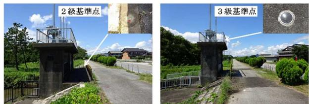
写真-5 2級・3級基準点(水門等に設置)
