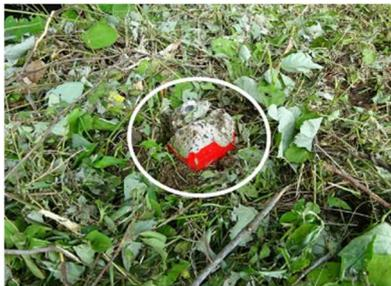
写真-2 損傷した境界杭
