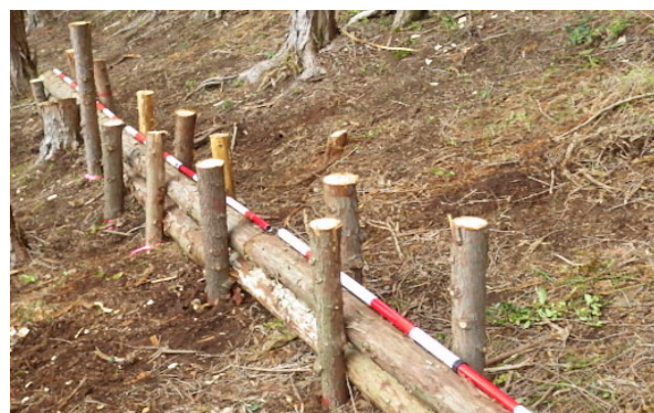
写真-3 試験施工完成状況
