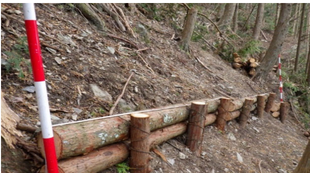
写真-1 従来型の丸太筋工
