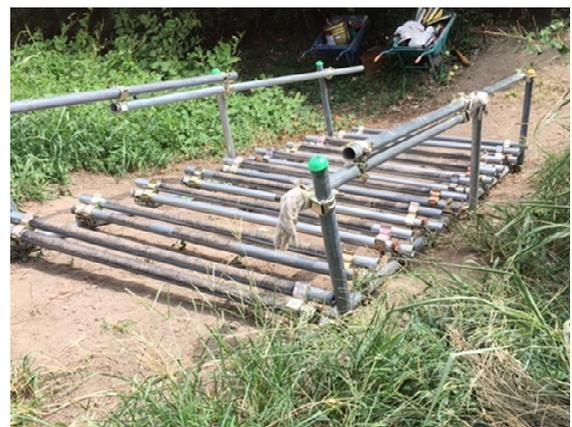
写真-1 堤体に設置された階段
