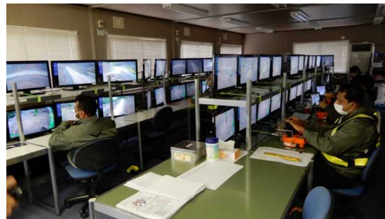
写真-1 無人化施工の操作室内の様子
