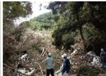
長殿での現地調査の様子
