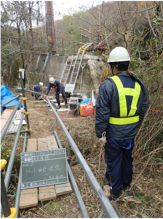
写真-5 東谷堰堤の現場状況
