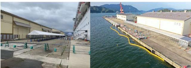
図-7 クルーズ船仮設屋根付き通路の設置状況
