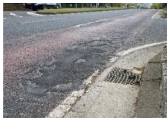
【損傷度 III : 修繕段階】
