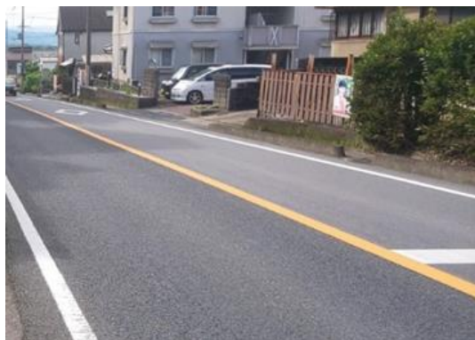
【損傷度 I : 健全】
