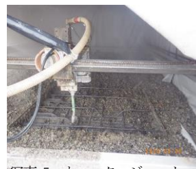
写真-5 ウォータージェット研り状況
