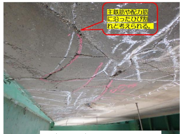
写真-4 ブロック状のひびわれ
