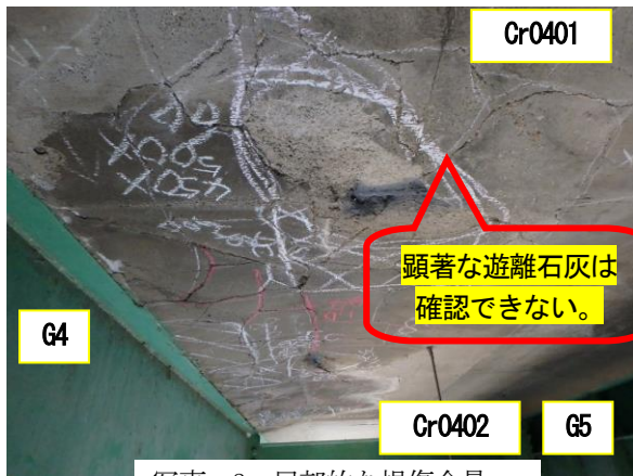
写真-3 局所的な損傷全景
