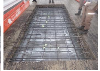
写真-6 取り壊し後
