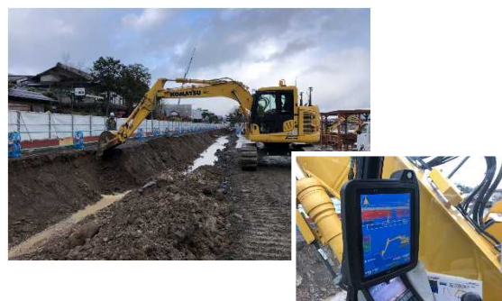
図-14 ICT建設機械による掘削状況
