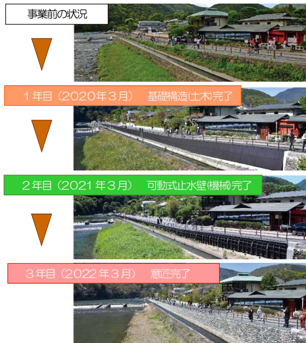
図-2 可動式止水壁設置工事における3ヶ年の状況
