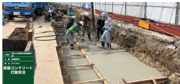
図-13 基礎構造の施工状況
