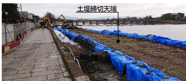
図-12 大型土のうによる土堤締切
