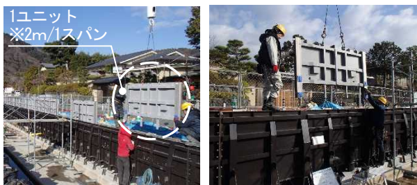
図-15 可動式止水壁の吊り込み状況
